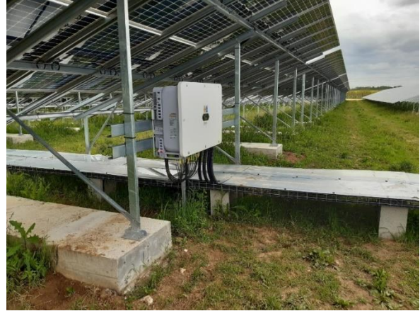
Exemples de câblages hors sol non intrusif
