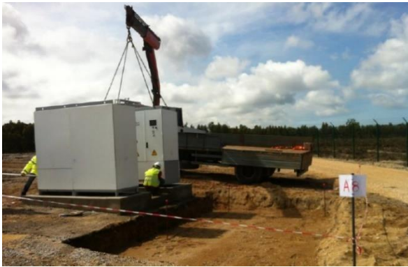
Installation des postes de conversion :
