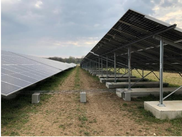
Exemples de câblages hors sol non intrusif
